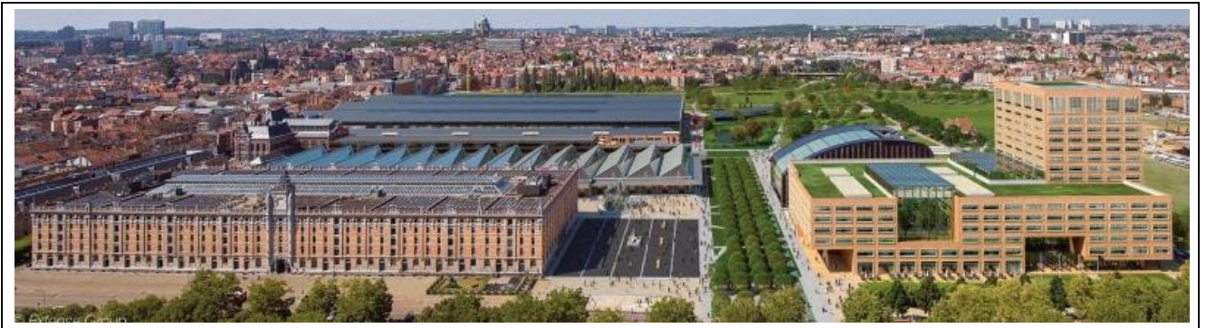
Het Herman Teirlinckgebouw op de site van Thurn & Taxis (copyright Extensa, project T&T)
